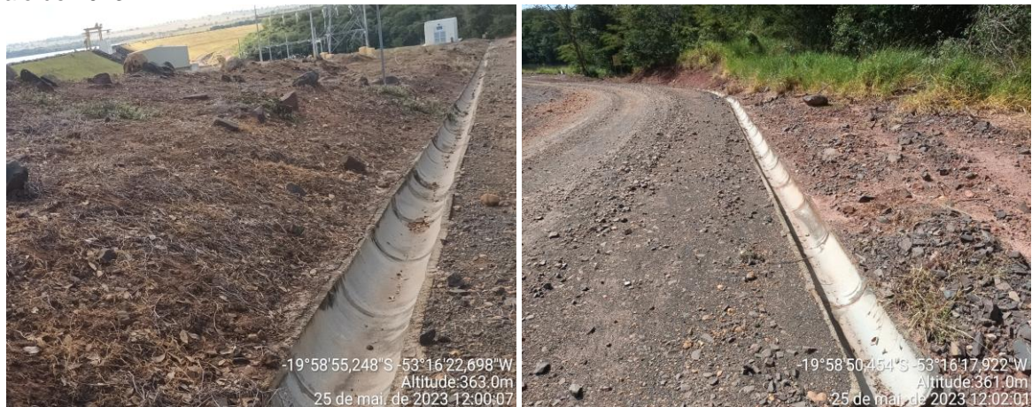
Figura 9. Caneletas de escoamento da PCH Verde 4; Município de Água Clara/MS. Campanha de maio de 2023.
