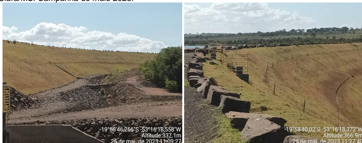
Figura 7. Taludes da PCH Verde 4, contendo área cascalhada e gramada. Município de Água Clara/MS. Campanha de maio de 2023.
