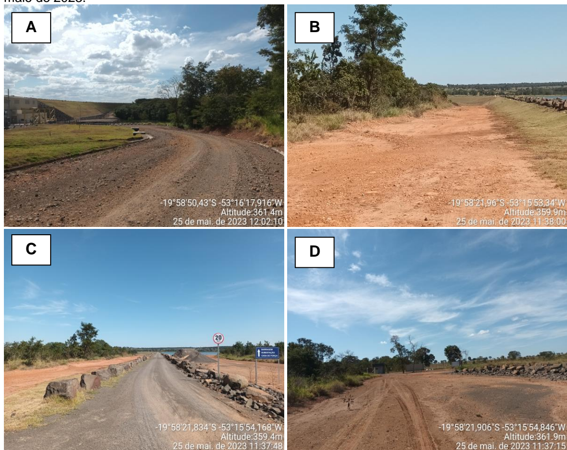
Figura 8. Estradas de acesso interno da PCH Verde 4 em estado apropriado: (A) acesso a casa de força; (B) acesso a margem esquerda da jusante; (C) acesso ao barramento; (D) acesso a guarita e portão; (E) acesso a subestação; (F) acesso a jusante. Município de Água Clara/MS. Campanha de maio de 2023.
